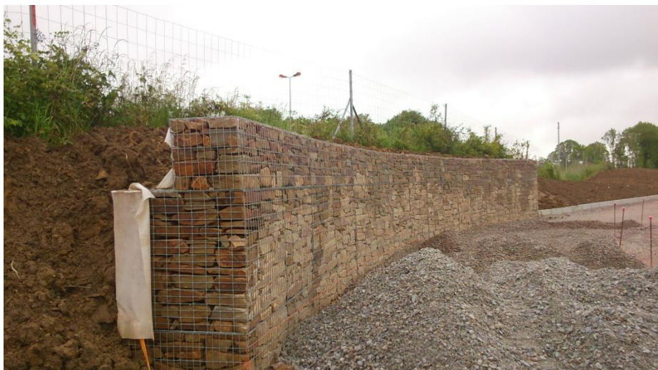
Les murs en gabions
